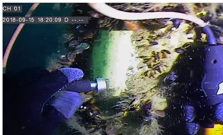
Фигура 5. Снимка от провеждане на подводна ултразвукова дебелометрия на подводните съоръжения.
